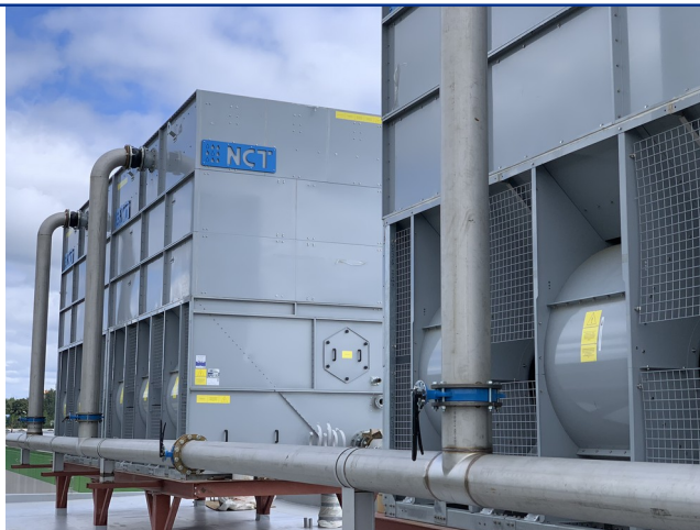
Закрытая градирня NCT на крыше промышленного объекта. Серебряный корпус, синий лейбл бренда, водяные трубы — то, что охлаждает AI-кластер вместо фреонового чиллера
