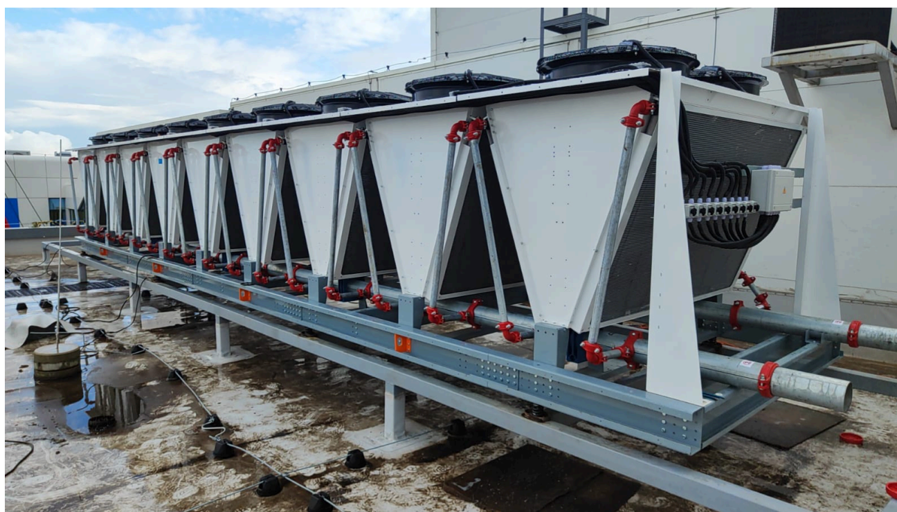
Рисунок 43 Ряд V-образных драйкулеров NCT на кровле производства жидких пестицидов, Республика Татарстан
