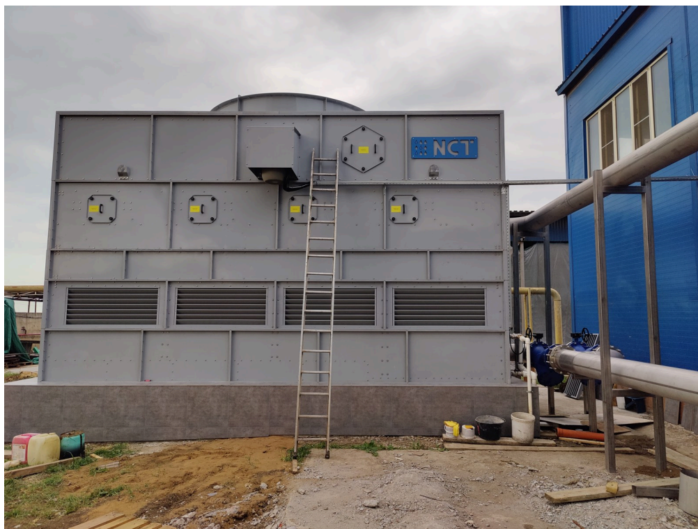
Рисунок 5 Открытая градирня NCT серии VA: осевой вентилятор большого диаметра сверху, воздухозаборные жалюзи по периметру
