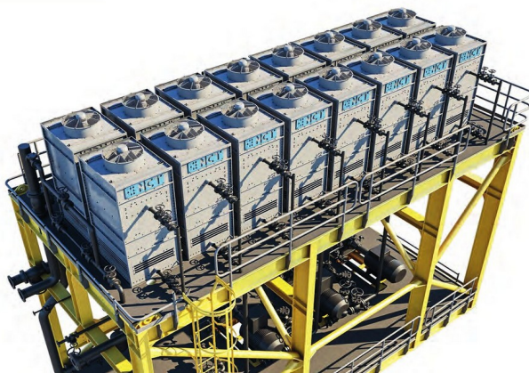
Открытые градирни NCT на промышленной эстакаде — типовая площадка для систем оборотного водоснабжения.
